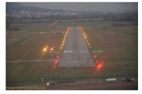
und Rollwegbefeuerung (Runway Lights / Taxiway Lights) z.B. auch das APAPI, die Hindernisbefeuerung (Obstacle Lights) oder die Flashes (Blitze). Für die Runway Lights und APAPI stehen verschiedene Intensitätsstufen 7ur Verfügung. Diese werden vom **ATCO** dem Tageslicht entsprechend ausgewählt. Während tagsüber die Intensität normalerweise bei 100% liegt,
